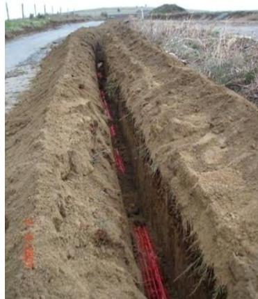
Réalisation de la tranchée et de la pose du câble simultanément
