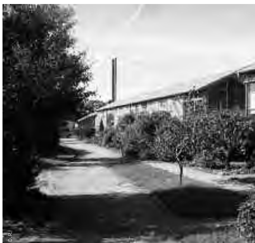
▲ Autres logements sociaux avec, au fond, les cheminées de la chaufferie bois.
