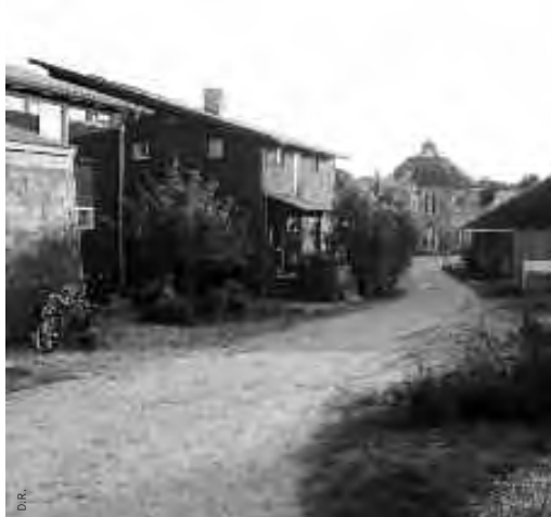
▲ Les premières maisons construites sur le site (groupe 1)
