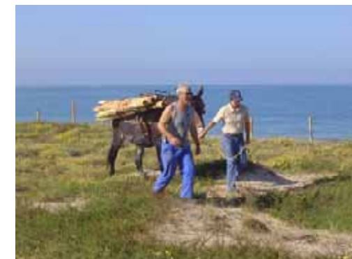
Mule poitevine au bât Chantier de réfection de clôture, dunes des Seulières, Saint-Denis d'Oléron
