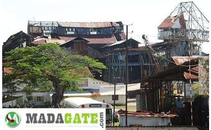
21/11/09 Sirama Djamanjary - Des infrastructures en délabrement très avancé... Andry Rajoelina est entré en pré-campagne. Il est intervenu à Brickaville et à Nosy Be en faveur des centaines d'employés de la société sucrière Sirama dont les salaires accusent un arriéré de paiement de plusieurs années. La Sirama, société d'Etat, est en voie de privatisation. Madagascar importe du sucre.
