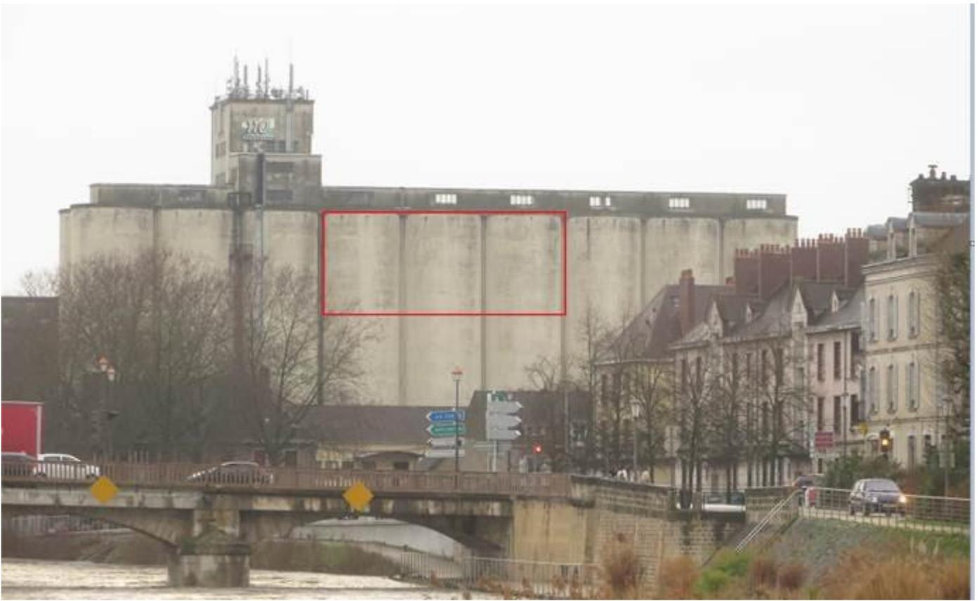
Chaque cellule du silo fait 24 m de haut pour un diamètre de 7,22m. L'arc de cercle pour chaque cellule est donc approximativement de 11m, soit une surface à peindre de 15m de haut sur 33m de large.
